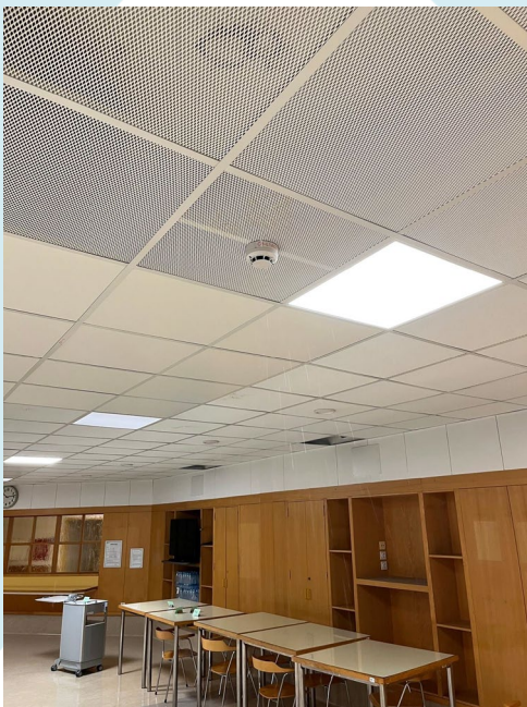
Primer zmontiranega stropa
